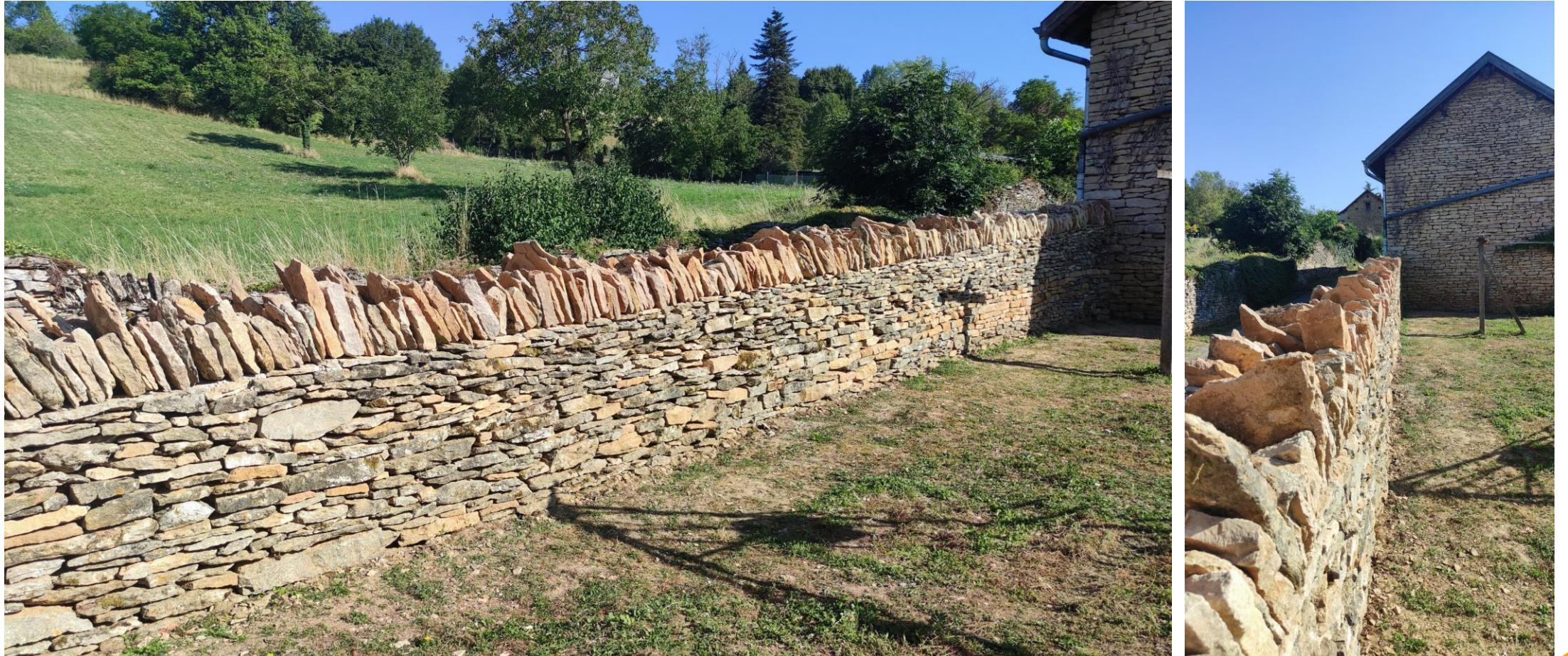
\* Couvertine en clavade est une technique de pose des pierres debout sur le sommet du mur. Elle permet notammentnt de protéger le mur des infiltrations.
